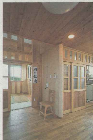
母親世帯も内装は木と漆喰仕上げ。引き戸上部は無双窓とし、風と光を行き渡らせ、明るく心地良い空間に
